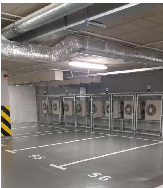
Foto. Parking podziemny
